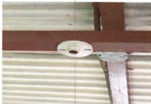
Foto 8: Sustitución de focos por lamparas tipo led en Modulo 1.
