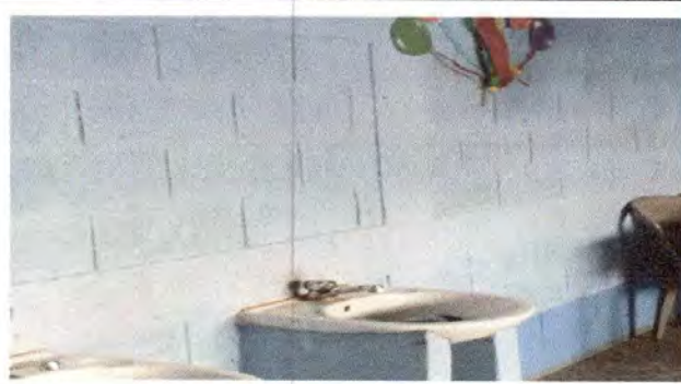
Foto 4: Pintura en interior del modulo 2 de aulas y baños
