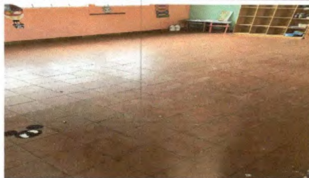
Foto 2: Sustrucción de piso de torta por piso ceramico de 2 aulas y 1 bodega del modulo 1.
