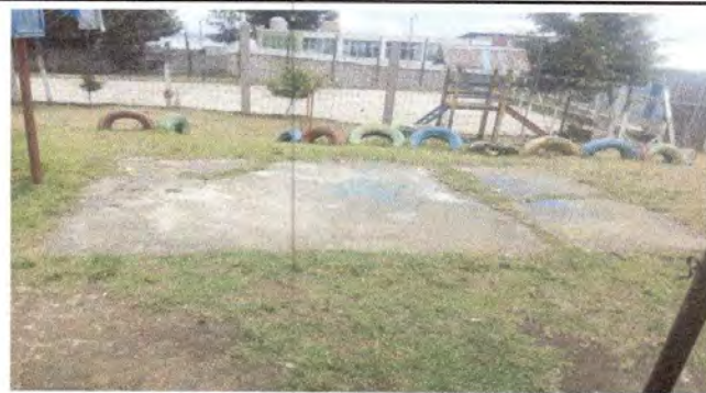
10. Reparación de piso de torta de concreto modulo 1
