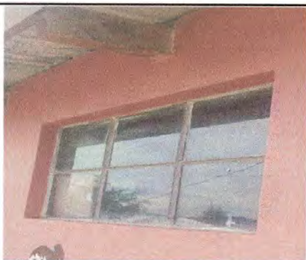
9.- Colocación de balcon en area de baños.
