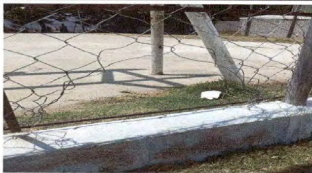
7. Sustitución y reparación de malla en circulación en modulo 2
