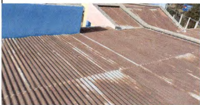
Foto 1: Sustrucción de lamina por lamina troqueleada aluzinc calibre 26 en modulo 1 de aulas, cocina y bodega
