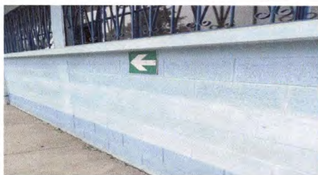
Foto 3: Pintura en exterior del modulo 2 de aulas y baños
