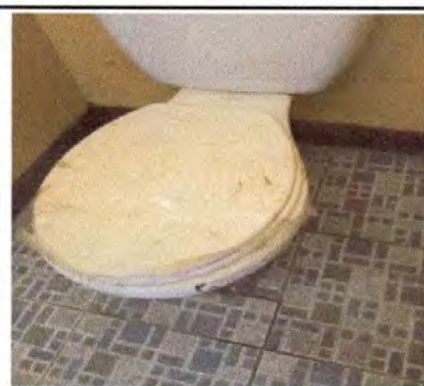
Foto 5: Sustrucción de 3 inodoros en modulo 1 de baños.
